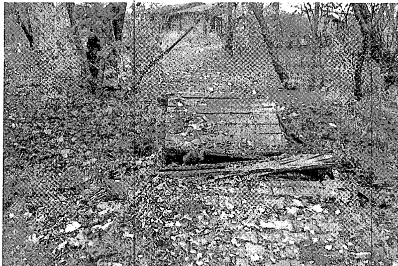
Alee pavata deteriorata ce trebuie reamenajata
